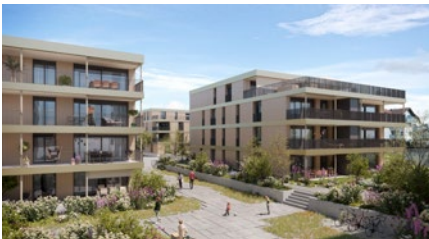
Wohnüberbauung in Diepoldsau
