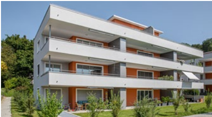
Mehrfamilienhaus in Tagelswangen
