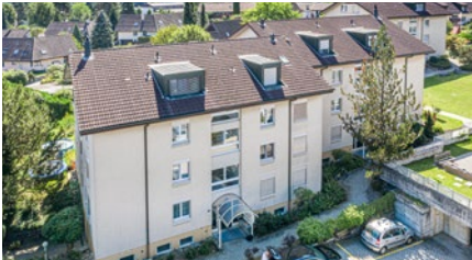
Wohnüberbauung in Münchenbuchsee
