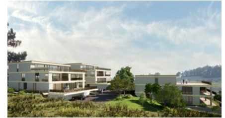
Wohnüberbauung in Herznach
