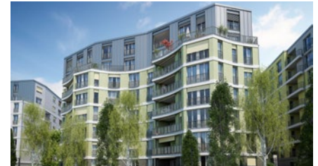
Überbauung «Glasi Haus Oscar» in Bülach
