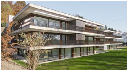
Überbauung «Rebacher» in Oetwil an der Limmat
