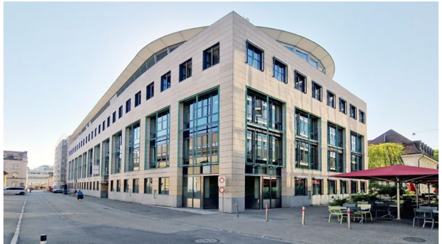
Wohn- und Geschäftshaus in Aarau
