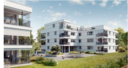
Wohnbauprojekt «Am Heuweg» in Aarau Rohr
