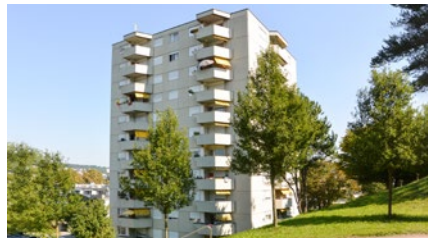
Mehrfamilienhaus in Schlieren
