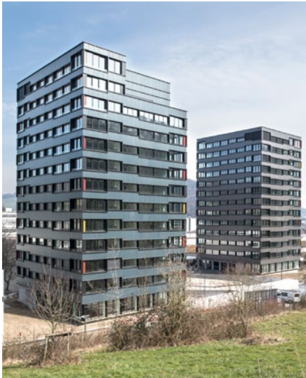
Wohnüberbauung «Belétage Martinsberg» in Baden
