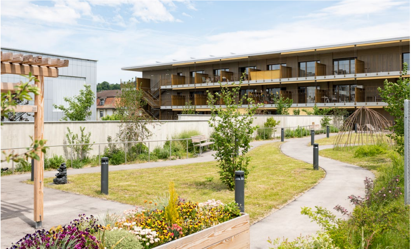
Erweiterungsbau: Demenzabteilung Senevita AG in Burgdorf
