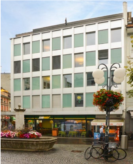
Geschäftshaus in Biel
