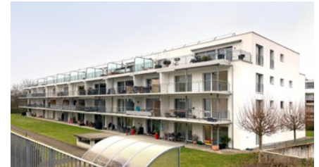
Wohnüberbauung in Olten
