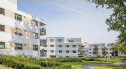
Wohnüberbauung «Eichbergpark» in Hombrechtikon
