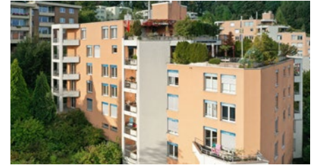
Mehrfamilienhaus in Luzern
