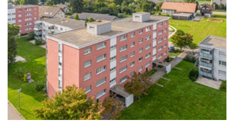
Wohnüberbauung in Rothrist
