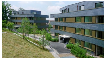
Wohnüberbauung «Classic Riehen» in Riehen
