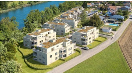
Wohnbauprojekt «Five Elements an der Aare» in Wangen an der Aare
