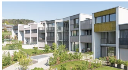
Überbauung «Im Feld» in Oberrohrdorf
