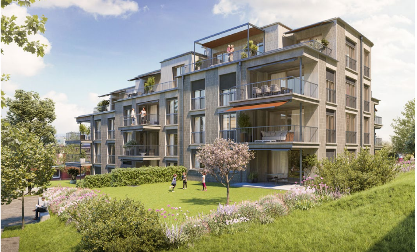
Neubauprojekt: Wohnüberbauung «Holderbachweg» in Zürich.
