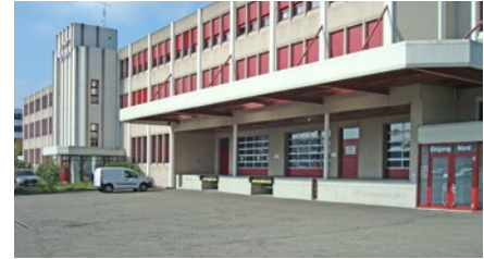
Gewerbegebäude in Weinfelden
