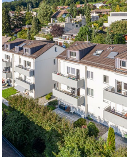
Wohnüberbauung in Hedingen
